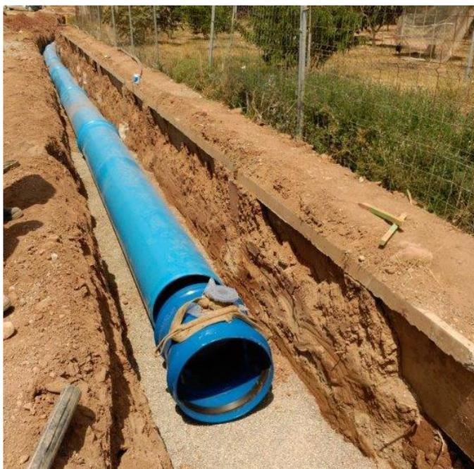
Ilustración 5.1. Zanja con tubería PVC-O 500 y pieza especial acoplada.
