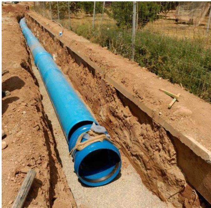
Ilustración 1. Zanja con tubería PVC-O 500 y pieza especial acoplada.
