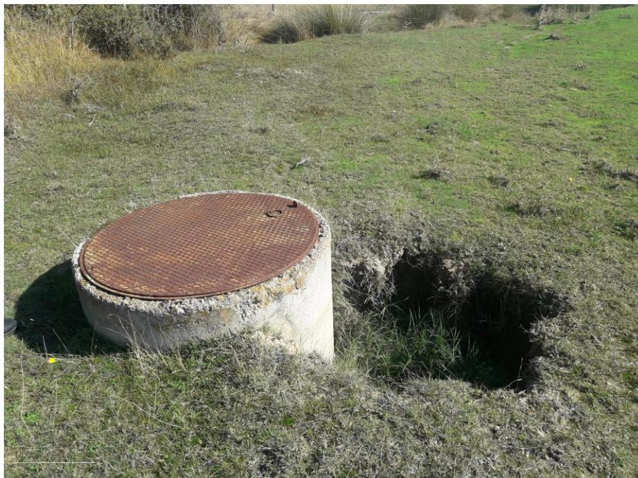
Socavón en desagüe debido a una mala evacuación del agua
